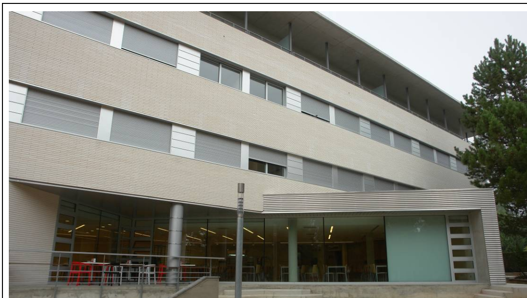
CMU Pablo Serrano, fachada lateral y acceso exterior al comedor universitario desde el campus.
