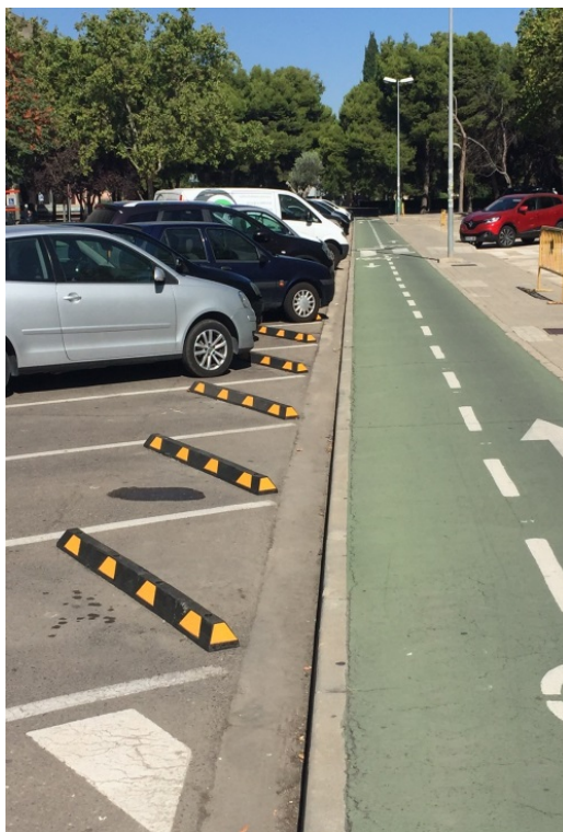
Ilustración 15: Instalación de límites en aparcamiento frente al ed. Interfacultades
