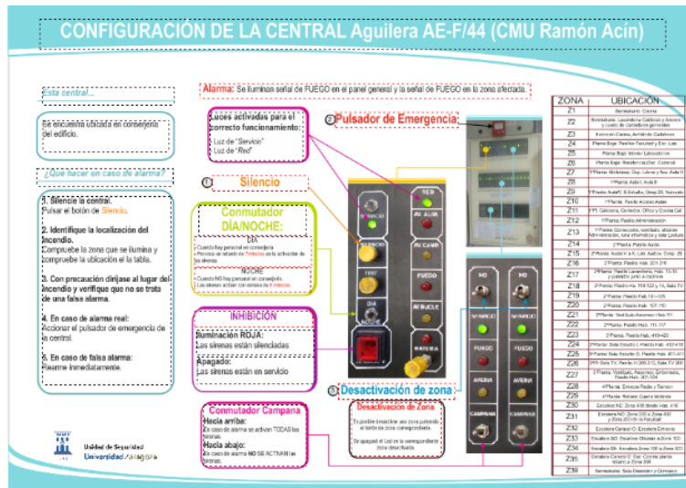
Ilustración 2: Cartel de la central de incendios de CMU Ramón Acín
