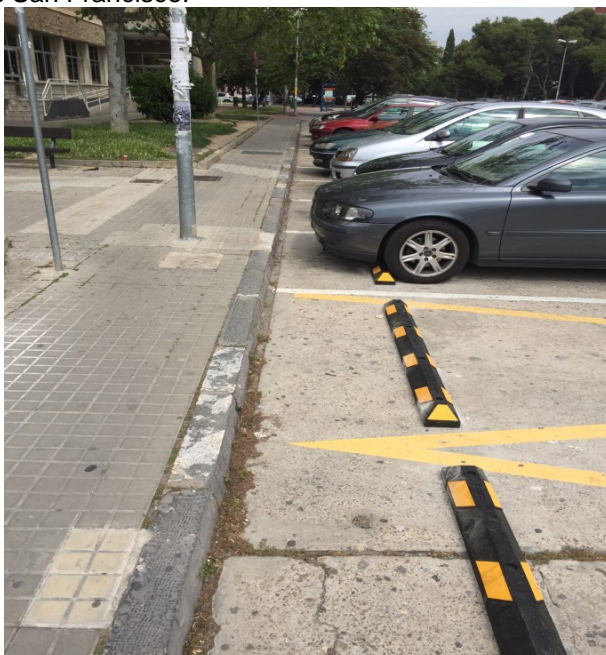
Ilustración 14: Instalación de límites en aparcamiento frente al ed. Interfacultades
