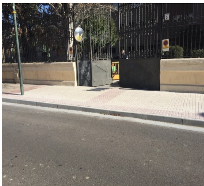
Ilustración 11: Eliminación del badén del CMU Santa Isabel
