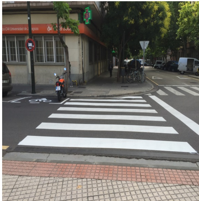
Ilustración 13: Pintado de paso de peatones en acceso a Biblioteca CAI-Universidad
