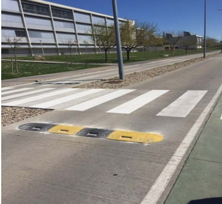
Ilustración 9: Pintado de paso de cebra en vial de acceso al aparcamiento Sur del ed. Betancourt
