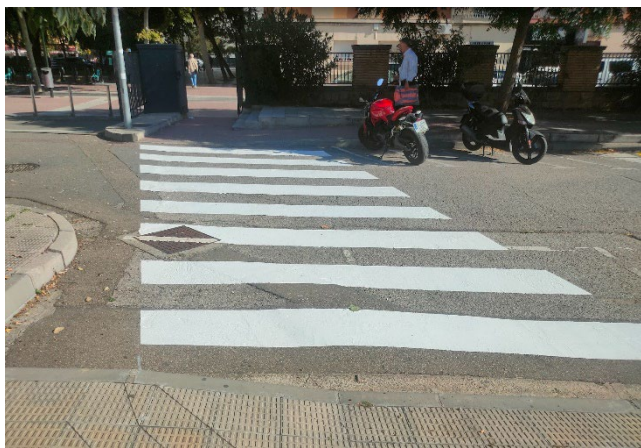
Ampliación paso cebra de la entrada de la calle Menéndez Pelayo
