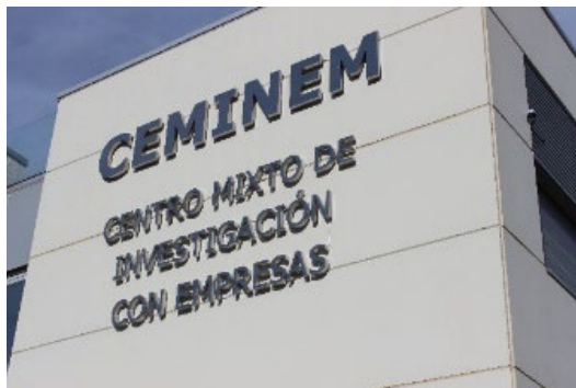
Edificio del Centro Mixto de Investigación con empresas
