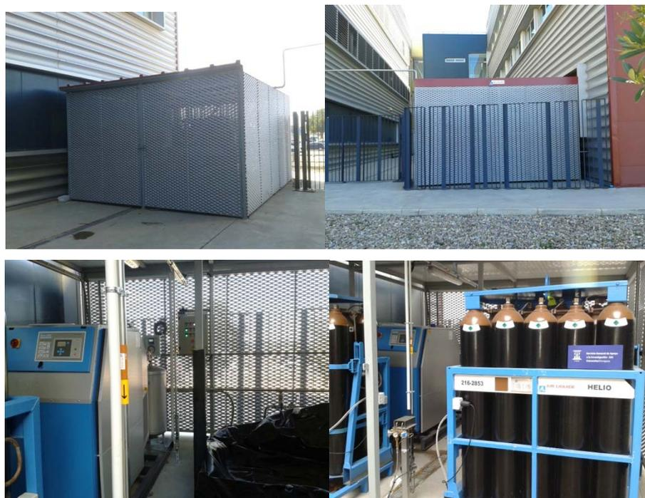
Figura 5. Edificio I+D+i Campus Río Ebro. Arriba fotografías del anexo de recuperación de Helio. Abajo a la derecha: Bloques de Helio gas. Compresor. Abajo a la izquierda: Globo y Sistemas de control.
