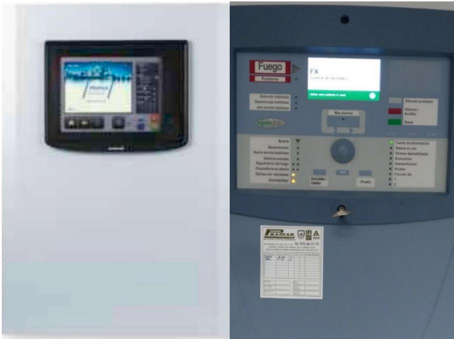
**Ilustración 11: Instalación de nuevas centrales de incendios en edificio Tozal de guara y edificio Interfacultades.**
