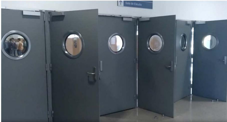
**Ilustración 10: Reparación de los elementos de sectorización de varias puertas del edificio Betancourt.**
