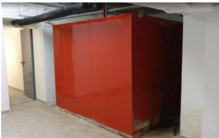
**Ilustración 9: Trabajos sobre aljibe de incendios del CMU Pedro Cerbuna. Presenta problemas de fugas y alto grado de corrosión.**
